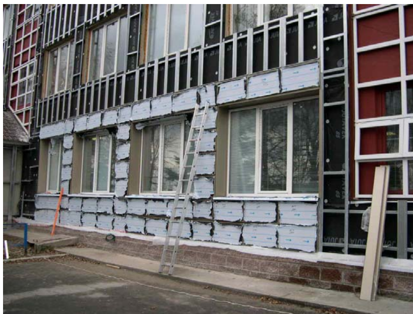
Рисунок 10. Монтаж фасадных кассет МП 2005 (2000)
