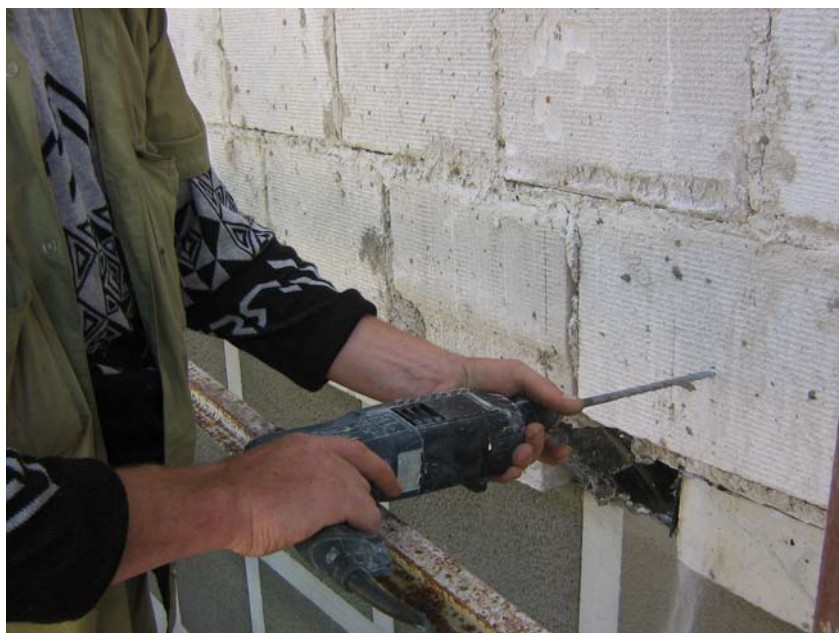
Рисунок 1. Сверление отверстий при помощи электродрели
