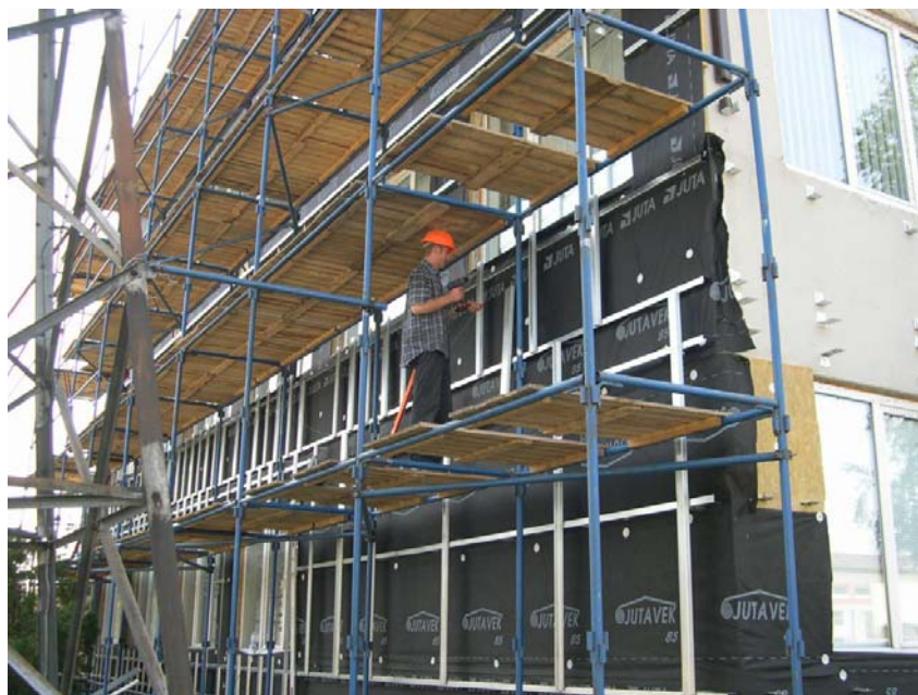
Рисунок 4. Монтаж каркаса
