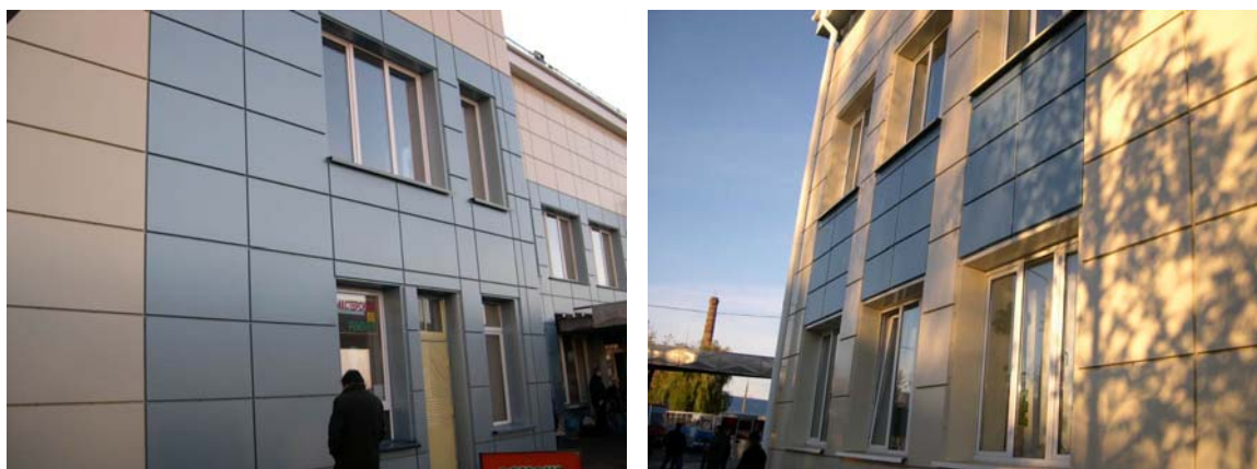
Рисунок 8, 9 Монтаж фасадных кассет МП 1005 (1000)
