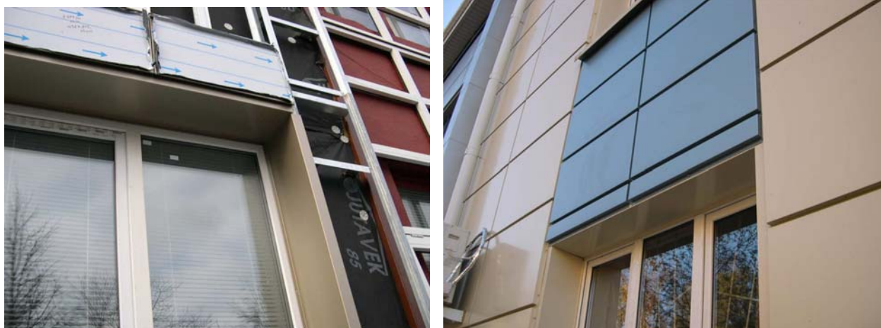
Рисунок 6. 7 Монтаж фасонных элементов
