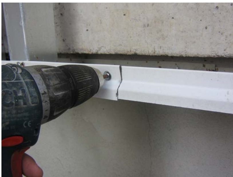
Рисунок 5. Монтаж начальной планки
