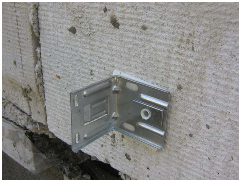
Рисунок 2. Крепление кронштейнов
